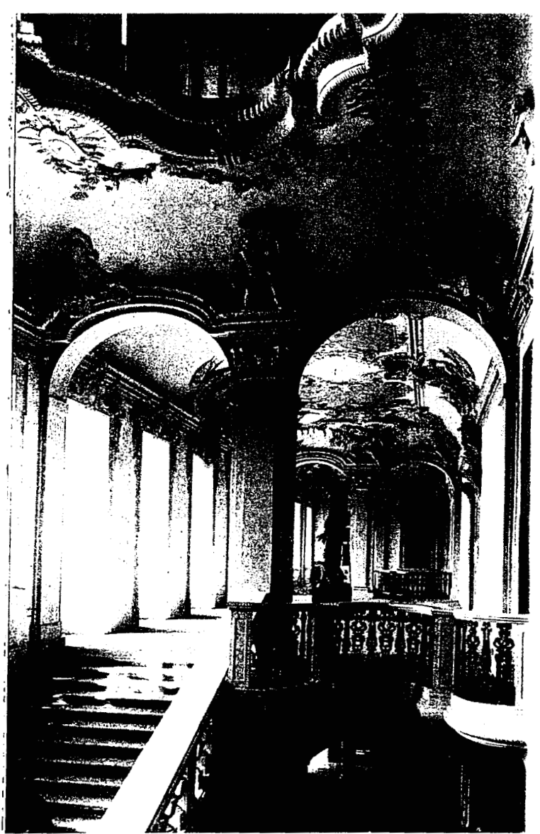
Treppenaufgang im Schloß
